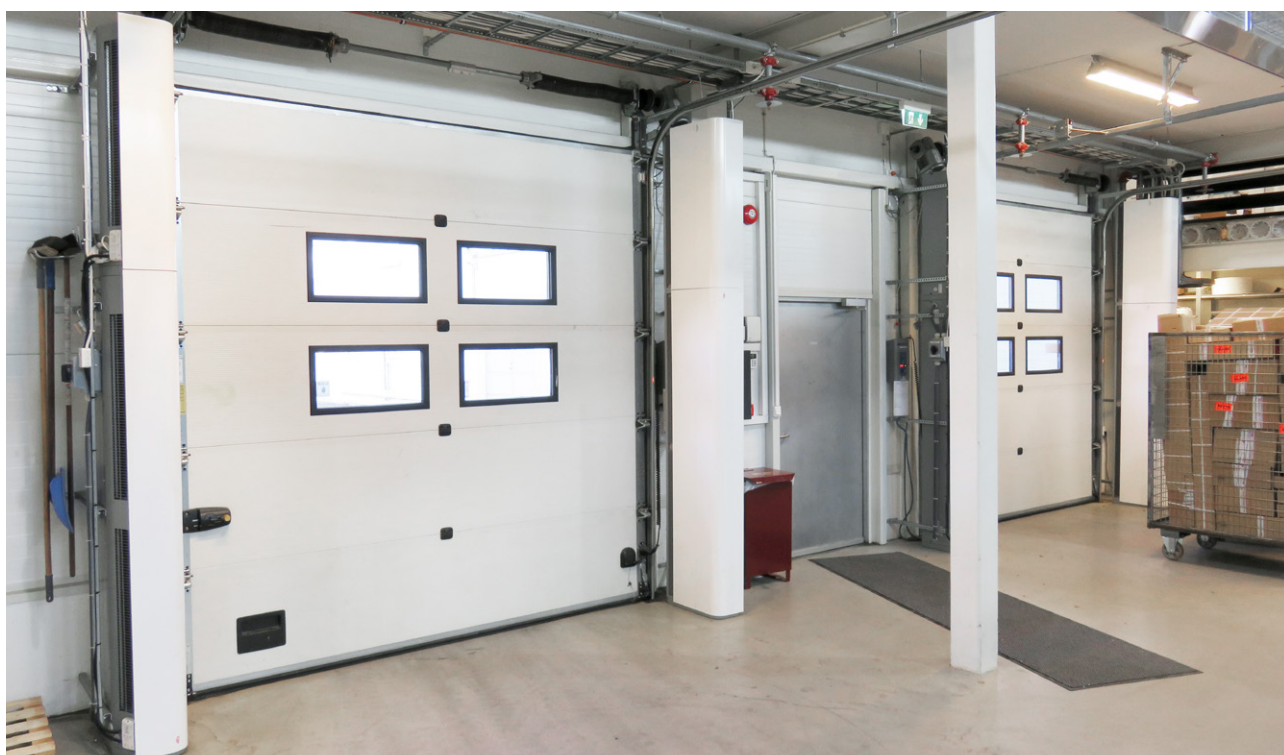
Der Einbausatz zur vertikalen Montage von Pamir 5000 ermöglicht es, zwei Einheiten übereinander anzubringen.
