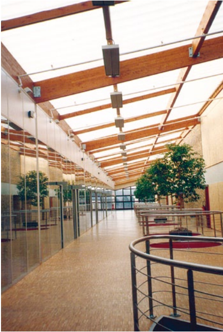
Les couloirs sont parfois difficiles à chauffer, toutefois, l'EZ100 monté au plafond diffuse de la chaleur avec précision, où elle est requise.
