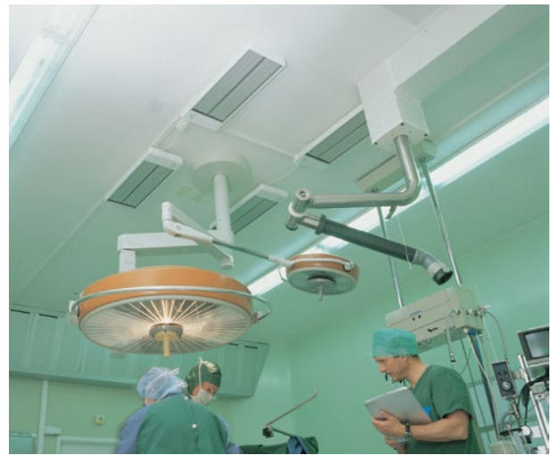
Le chauffage assuré par l'EZ200 est hygiénique, le système ne provoquant aucun déplacement d'air.
