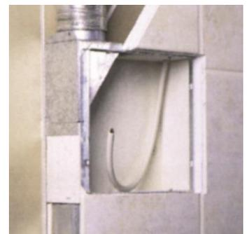
Unterputzgehäuse U in Trockenbauwand
